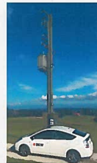
"Smarte" Neuerung: Regelbarer Ortsnetztransformator (RONT)
